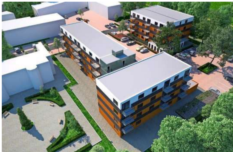
De gebouwen worden helemaal in de fabriek gemaakt. Op de bouwplaats worden de modules alleen op elkaar geplaatst, afgewerkt en de galerij gebouwd.
