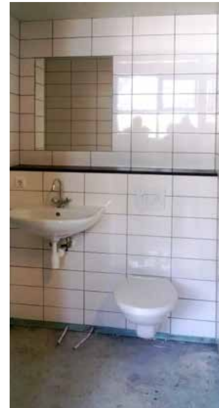
De badkamers werden inclusief installaties en afwerking geleverd
