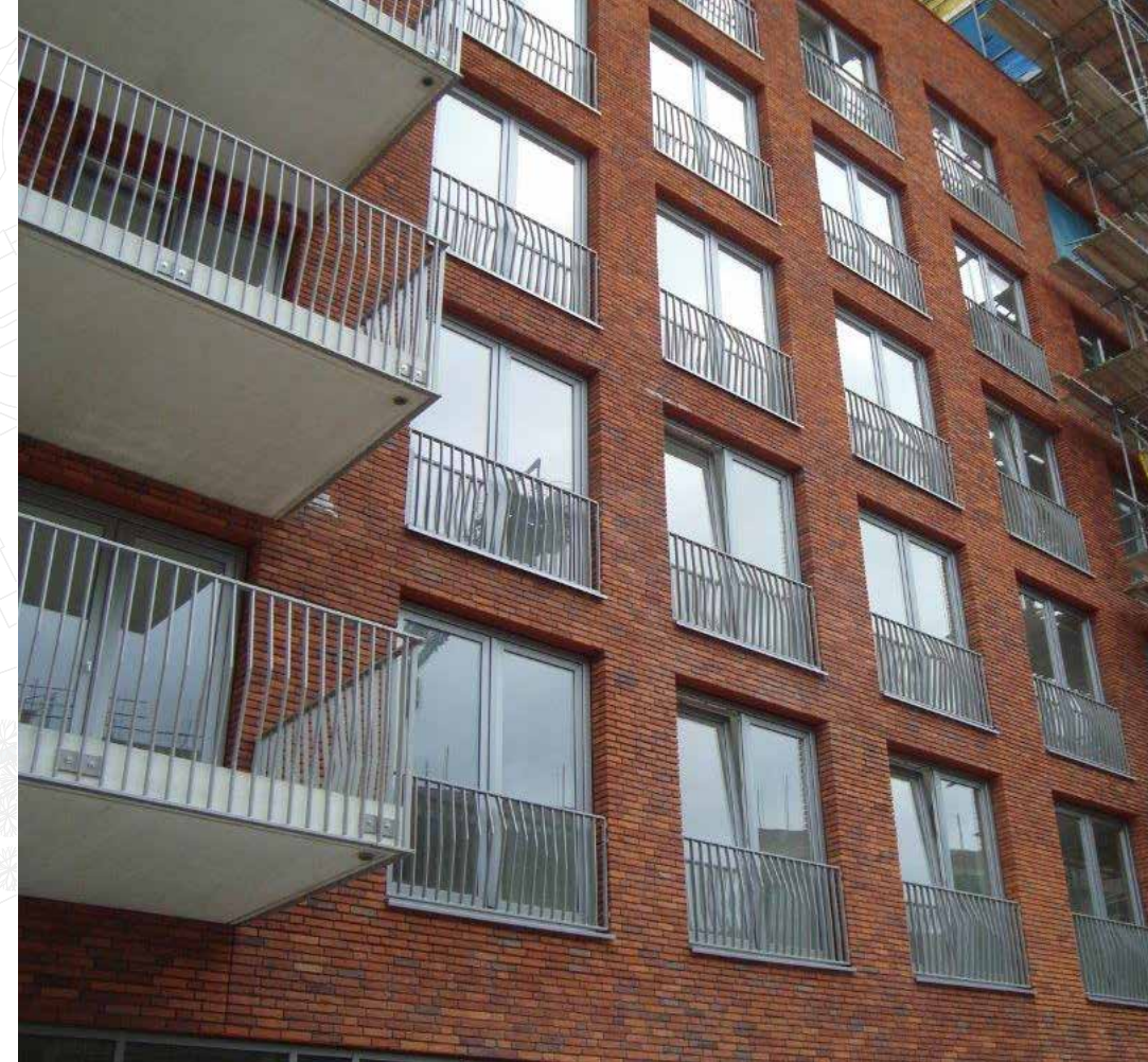
Kozijnen werden voormonteerd op de prefab spouwbladen aangeleverd
