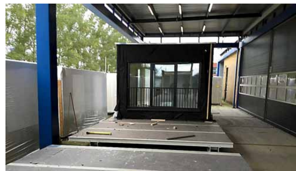
Een woning is al op proef gebouwd. Hier de halve bovenverdieping. FOTO'S HOLLAND MEDIA COMBINATIE
