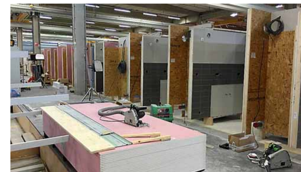
Serieproductie in de fabriek. Hier badkamers voor een ander project.
